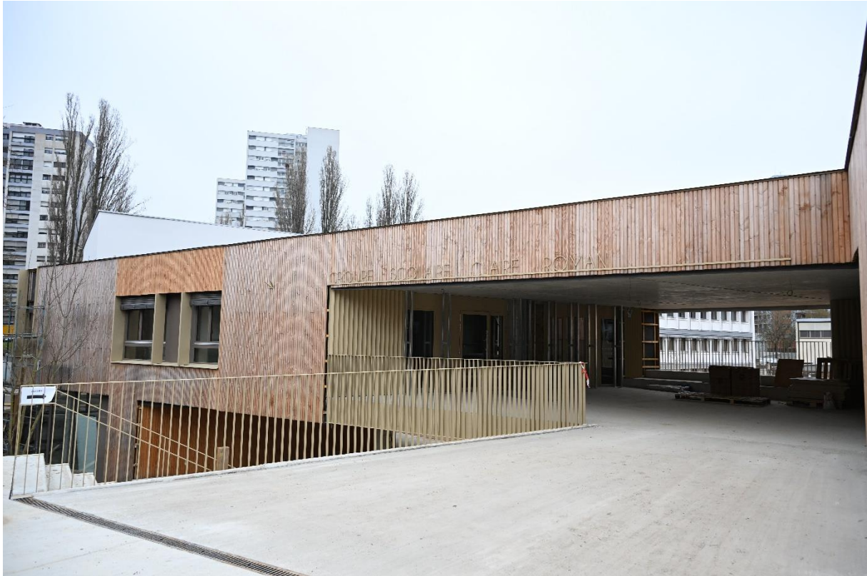
Un parvis commun et un grand auvent-hall font le lien entre l'ancienne école Camus et son extension.
