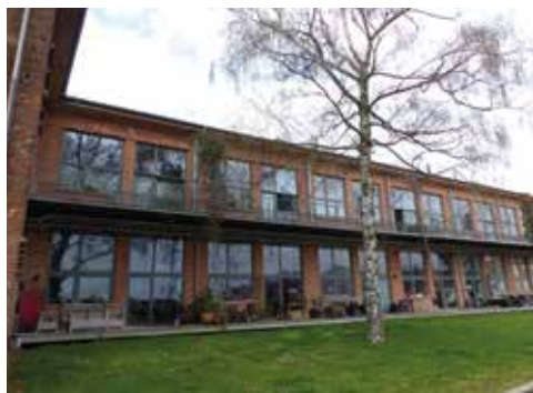
Un bâtiment de l'ancienne usine reconverti en lofts.
