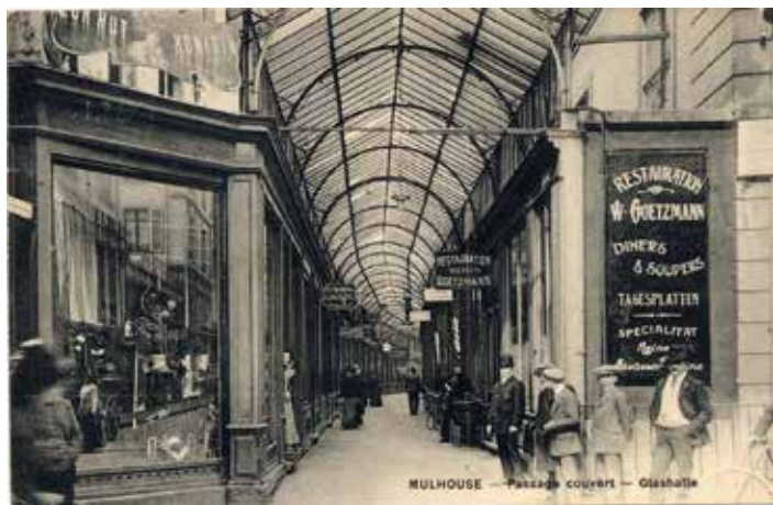
Le passage couvert aménagé sur le canal du Mittelbach.
